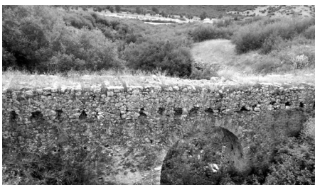
Εικ. 12. Διακρίνονται οι όπες στήριξης του ξύλινου πατώματος της γέφυρας.
