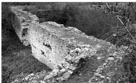
Εικ. 4. Η Β' ύδραγωγός γέφυρα του ύδραγωγείου.
