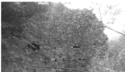
Εικ. 1. Ο τοίχος της υδραγωγού γέφυρας.
