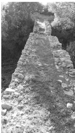
Εικ. 3. Τό κτιστό κανάλι του υδραγωγού.
