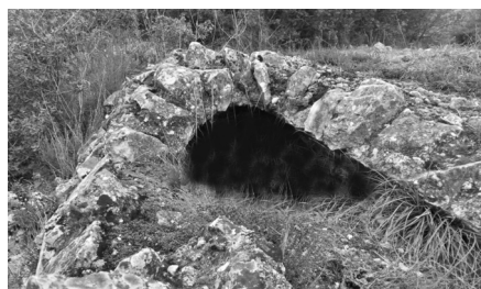
Εικ. 6. Ο υπόγειος κτιστός άγωγός του ύδραγωγείου.
