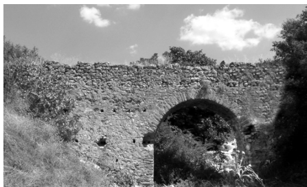
Εικ. 11. Η άκερρα υδραγωγός γέφυρα.
